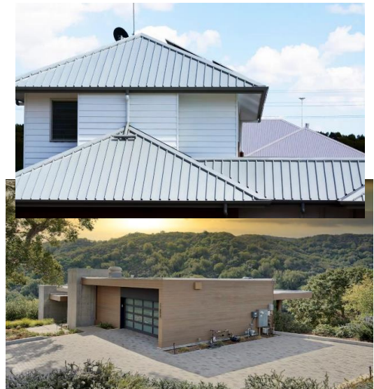
Figura 4. Ilustraciones de endurecimiento de viviendas que incluyen sustitución de tejados, retirada de hojas y limpieza de canalones, mejora de respiraderos, vallas metálicas y muros resistentes al fuego.
